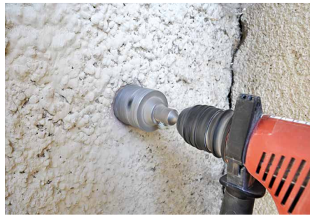
Abb. 6 a + b: Kernbohrungen in Mauerwerk
