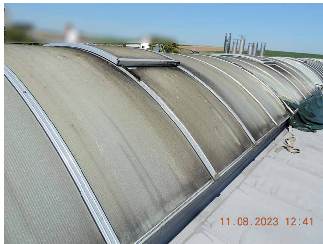
Abb. 3: Unbeschädigte Nordostansicht der Dachreiter (© ILS-Bau-Consulting)
