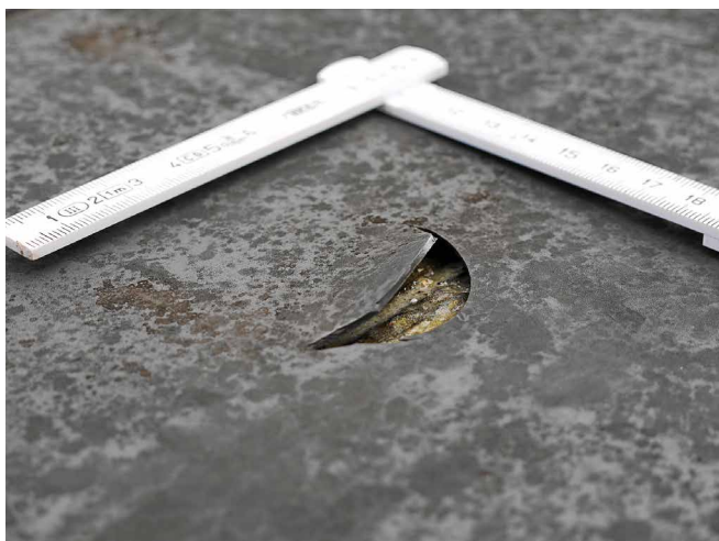
Abb. 6: Sichelartige Ausbrüche an Kunststoffbahnen-Abdichtung (© Dipl.-Ing. W. Holzapfel)
